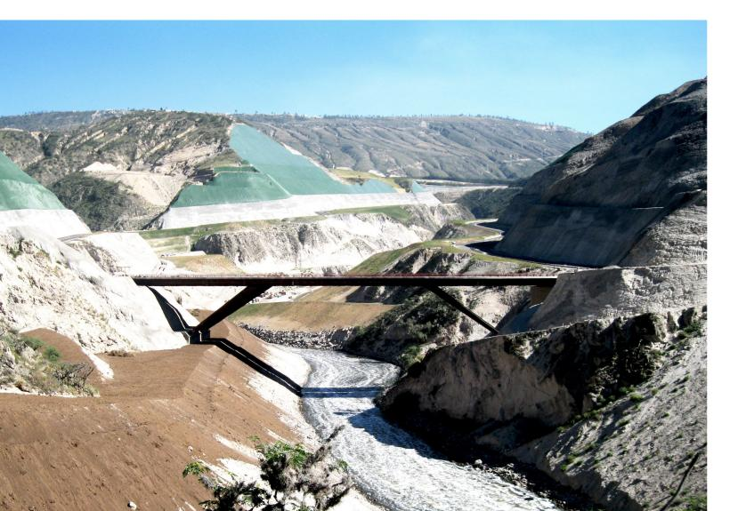
montaggio di tipo misto: i puntoni del cavalletto, sono stati installati e mantenuti in equilibrio attraverso l'utilizzo di cavi provvisori, la porzione ad asse rettilineo dell'impalcato metallico è stata varata di punta mentre le campate terminali sono state montate con autogrù.
